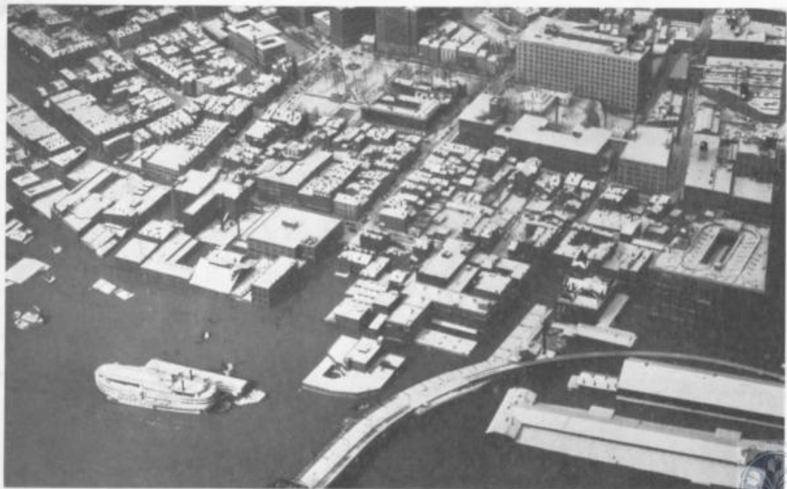
Cincinnati L. and N. Bridge.
